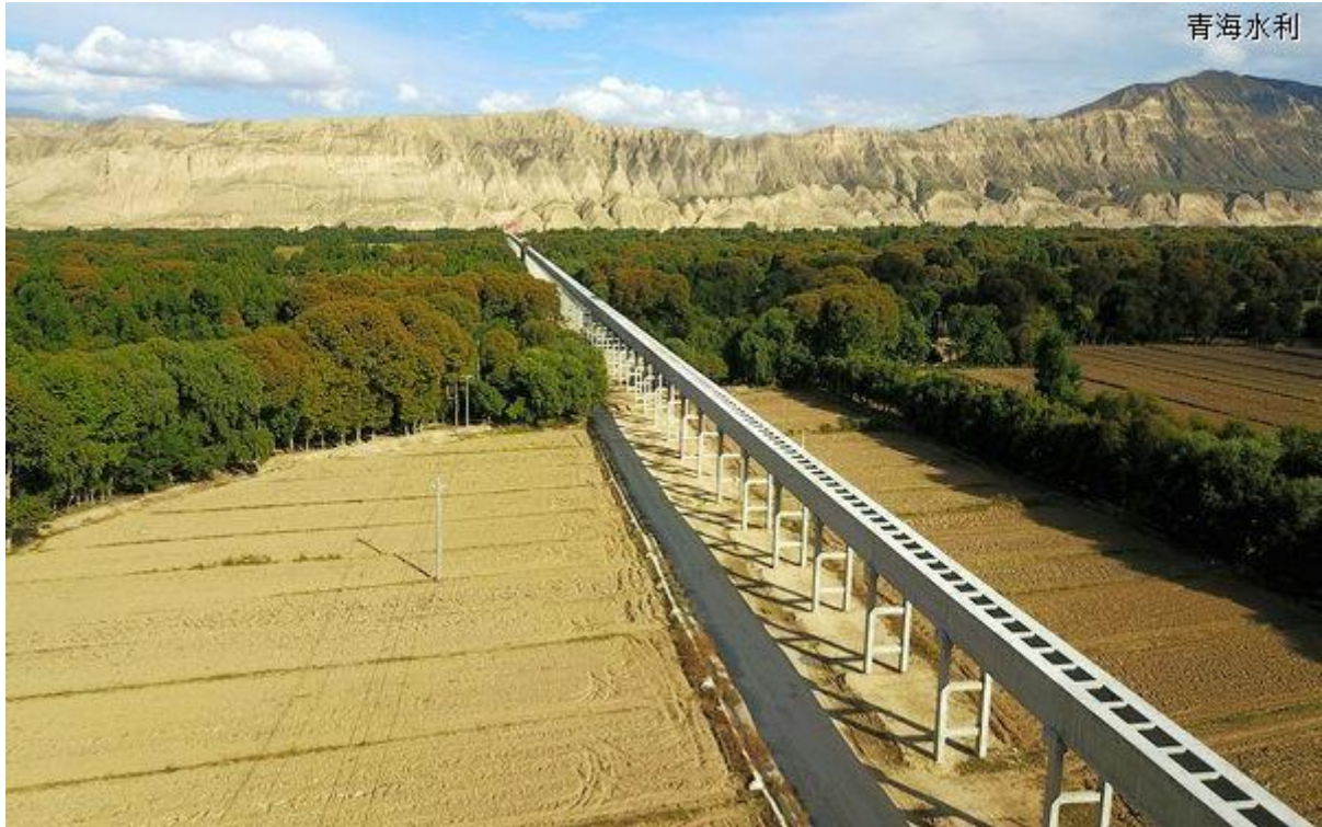
是辉煌——全长 2.7 公里横跨东西两山青海最长的拉西瓦灌溉工程渡槽。
