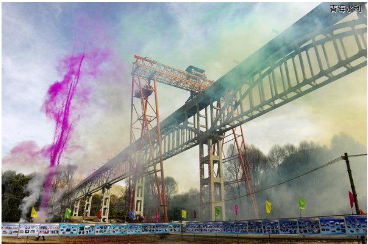
是骄傲——贵德县拉西瓦灌溉工程渡槽主体吊装合龙
